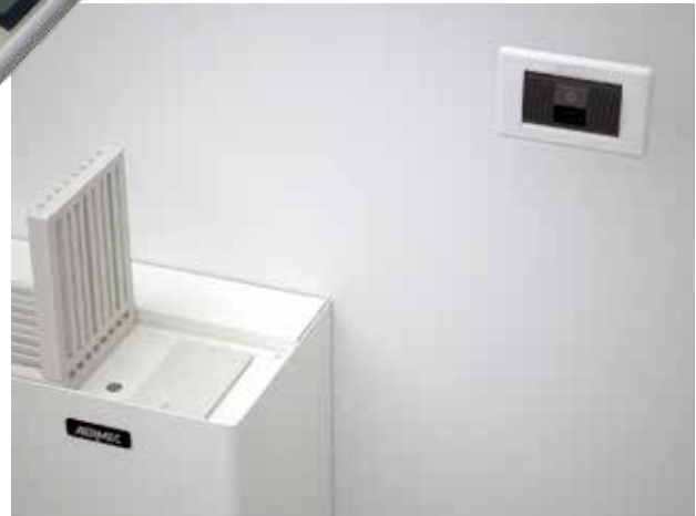
TL3-Empfänger an der Wand montiert
